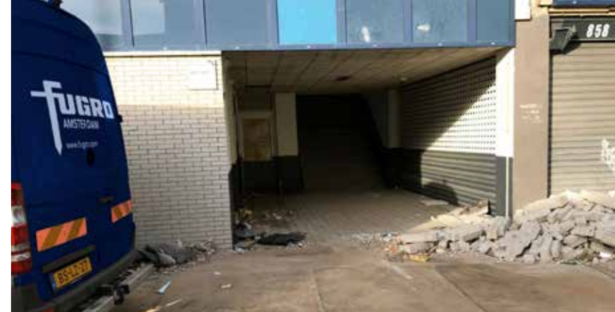
Fugro aan het werk om bestaande fundering in het bestaande gebouw te berekenen. (Beeld: Fugro)
