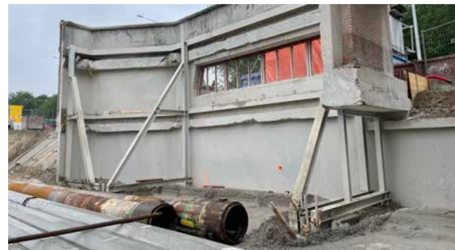
Bij de reconstructie, uitbreiding of complete nieuwbouw van bestaande bouwwerken wordt steeds meer de vraag gesteld of de reeds aanwezige prefab paalfundering (deels) hergebruikt kan worden. (Beeld: Van der Vorm)
