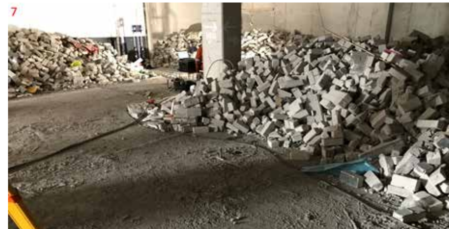
Aan de hand van archiefgegevens en onderzoek op locatie heeft Fugro de bestaande fundering in kaart gebracht en doorgerekend. (Beeld: Fugro)
