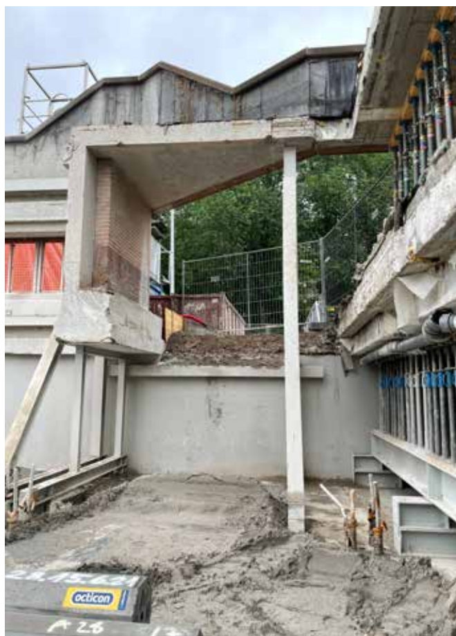
Opvangconstructie deels afsteunend op bestaande funderingspalen. (Beeld: Van der Vorm)
