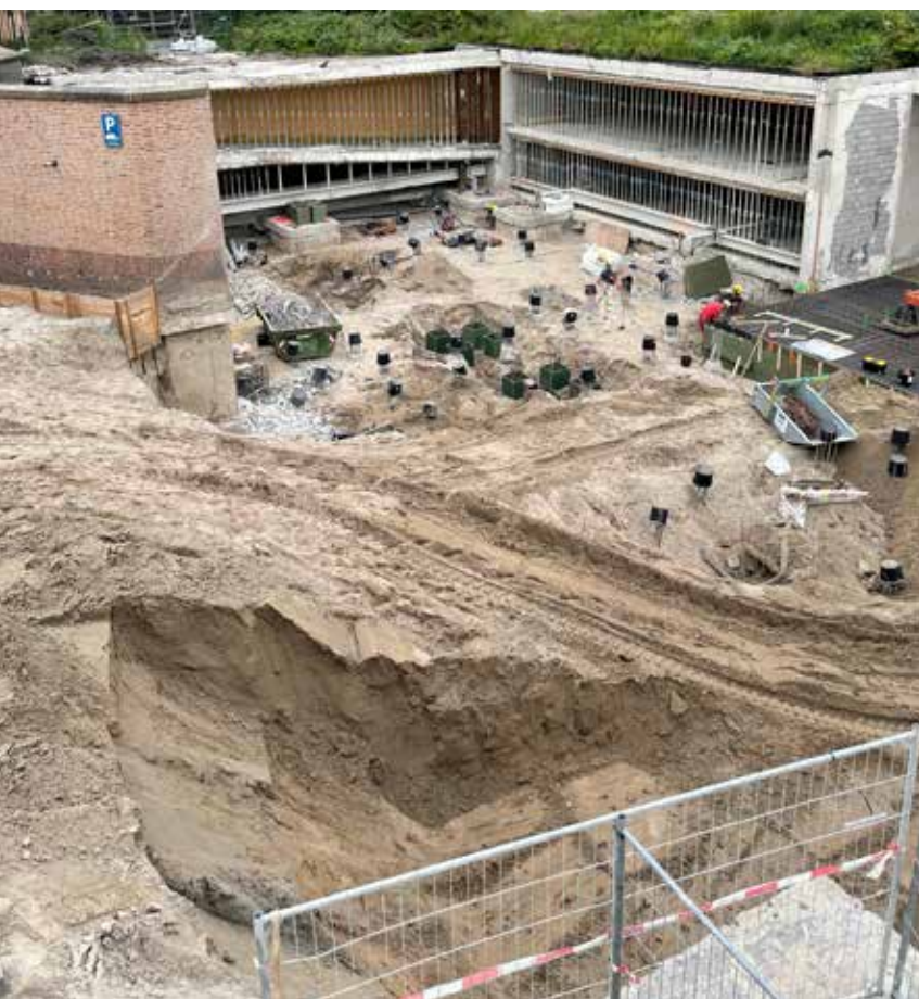
Nieuwe palen herkenbaar aan de zwarte emmers op de kop van de funderingspaal; de overige worden hergebruikt. (Beeld: Van der Vorm)
