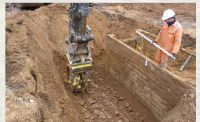
Fugro aan het werk. (Beeld: Fugro)
