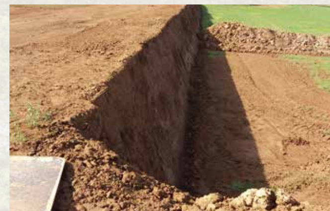
Steilranddijk in uitvoering. (Beeld: Fugro)
