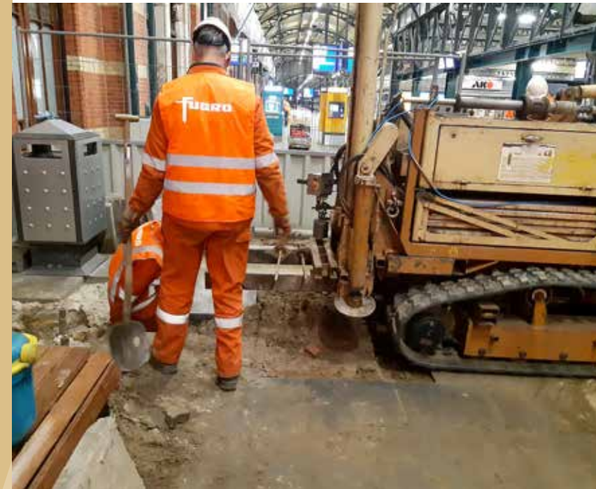
Door sonderingen en boringen te verrichten en bodemonsters in laboratoria te beproeven, brengt Fugro de opbouw en variatie van de ondergrond in beeld. (Beeld: Fugro).
