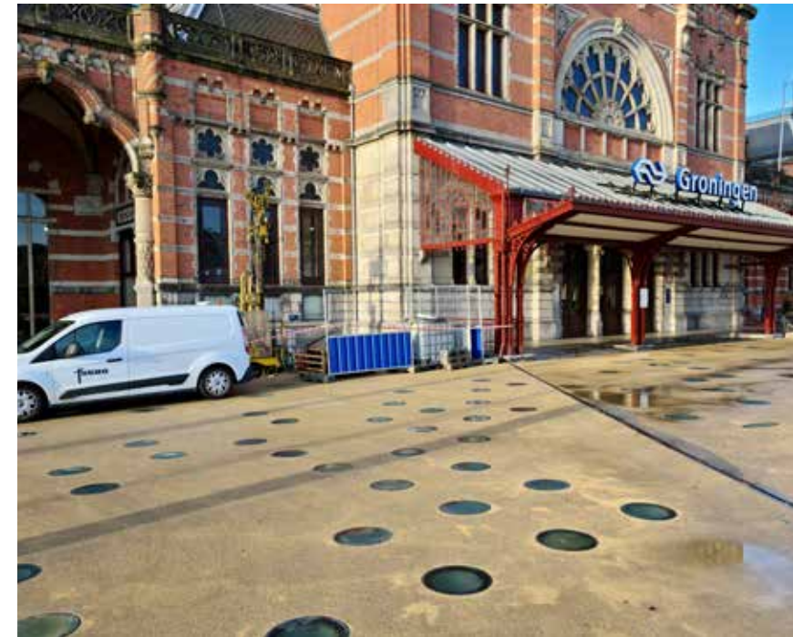
Station Groningen wordt getransformeerd van eindpunt naar transporthub. (Beeld: Fugro).
