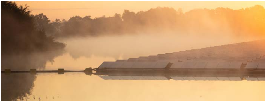
Het drijvende zonnepark bij het Drentse dorp Tynaarlo. (Foto: GroenLeven)
